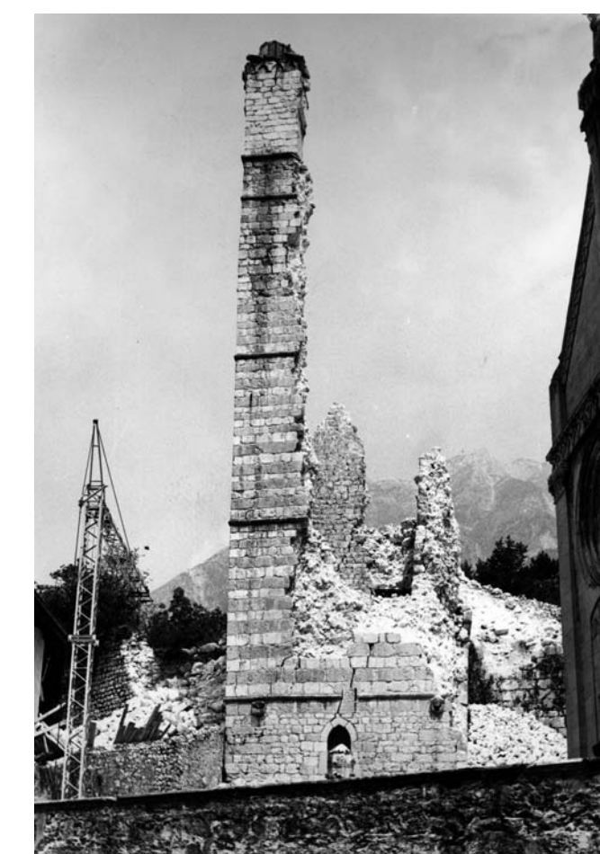
Foto 8. Friuli, terremoto del 6 maggio 1976 (Archivio DPC)
